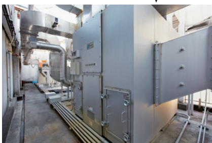
ヒートポンプユニットと 上部に設置されたVOC処理装置
