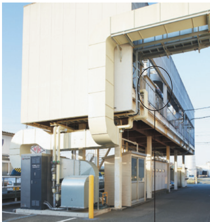
ヒートポンプユニットと 上部に設置されたVOC処理装置
